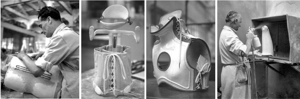
Fig. 14-1 : Fabrication de corset et de minerve. Peinture d'une emboîture fémorale en bois en 1957.
